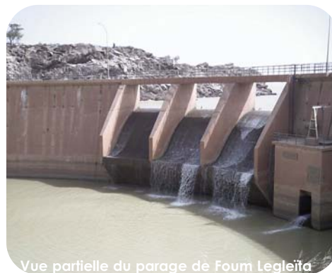
Vue partielle du barrage de Fom Legleïta
